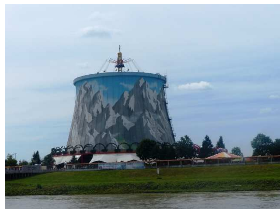
Kühlturm des „schnellen Brütters“ Kalkar
